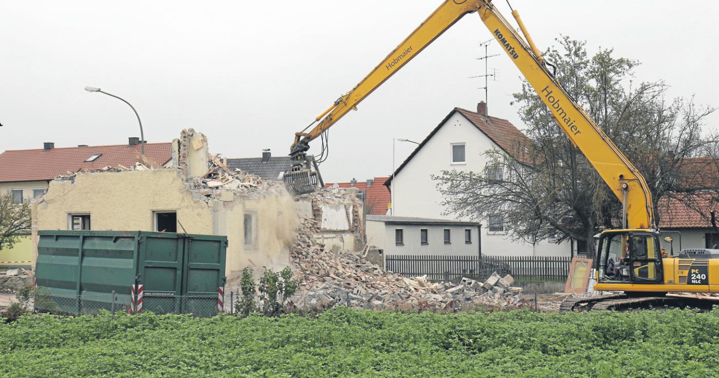
Ein Abrissbagger schuf in der letzten Woche Platz für den BusinessTower.La.
